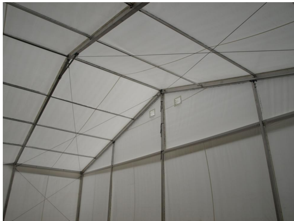
Konstrukcja hal namiotowych
