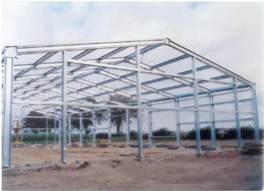
Konstrukcja hal w systemie „Practa”
